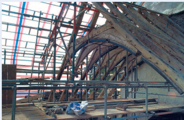
Рис. 15. Церковь Св. Кардока, Уэльс, Великобритания, во время капитального ремонта.
