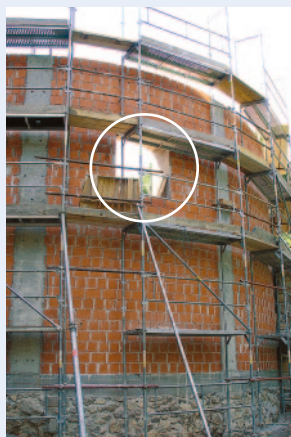
Рис. 16. Северо-западная башня замка «Град на Горичкем», Словения, во время и после реконструкции в 2006 г. (обведены новые входы в убежища рукокрылых).
